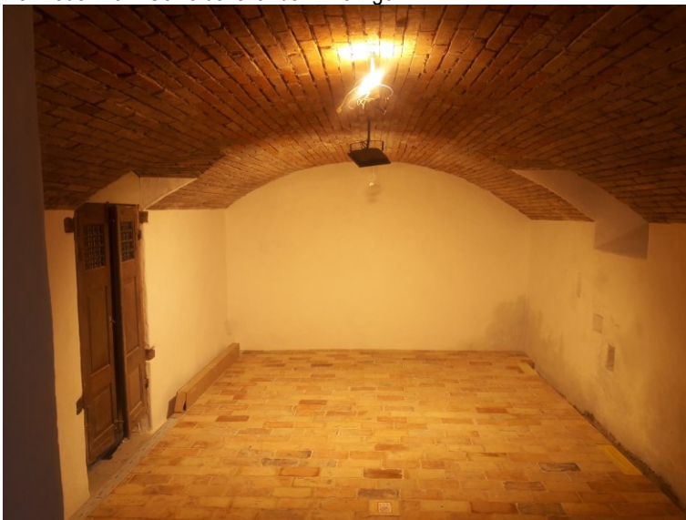
Der Tonplattenboden im eingebauten Zustand
