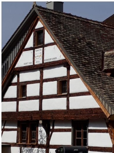
Details der fertigen Riegelfassade
