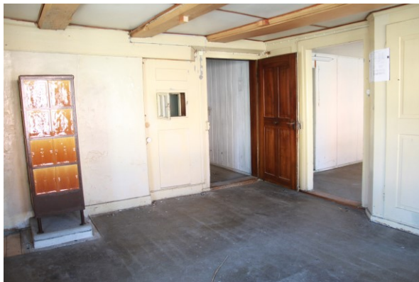
Wohnzimmer / Stube 1. OG vor dem Umbau
